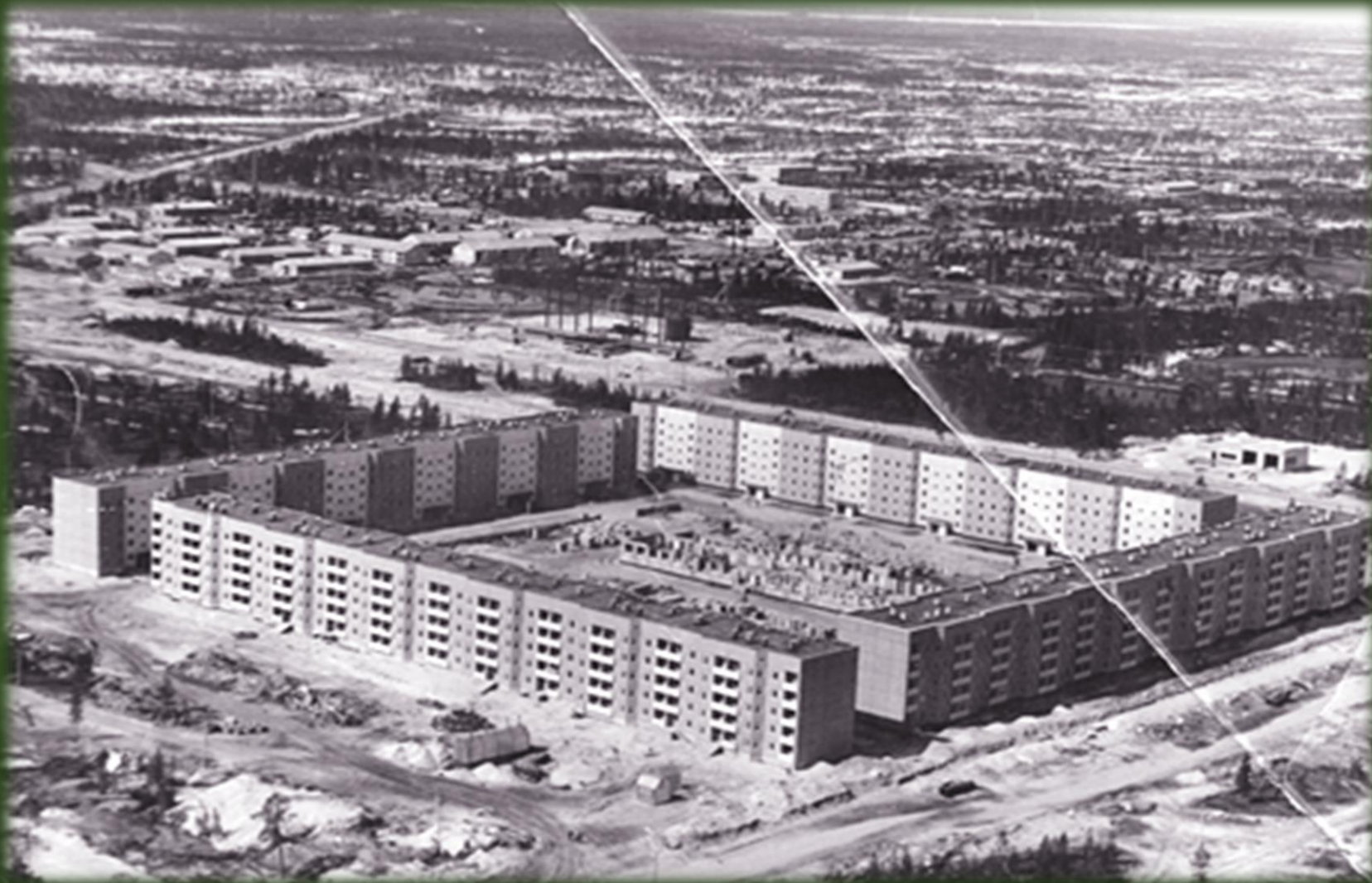
Строительство первого детского сада. п. Покачи, 1985 год
