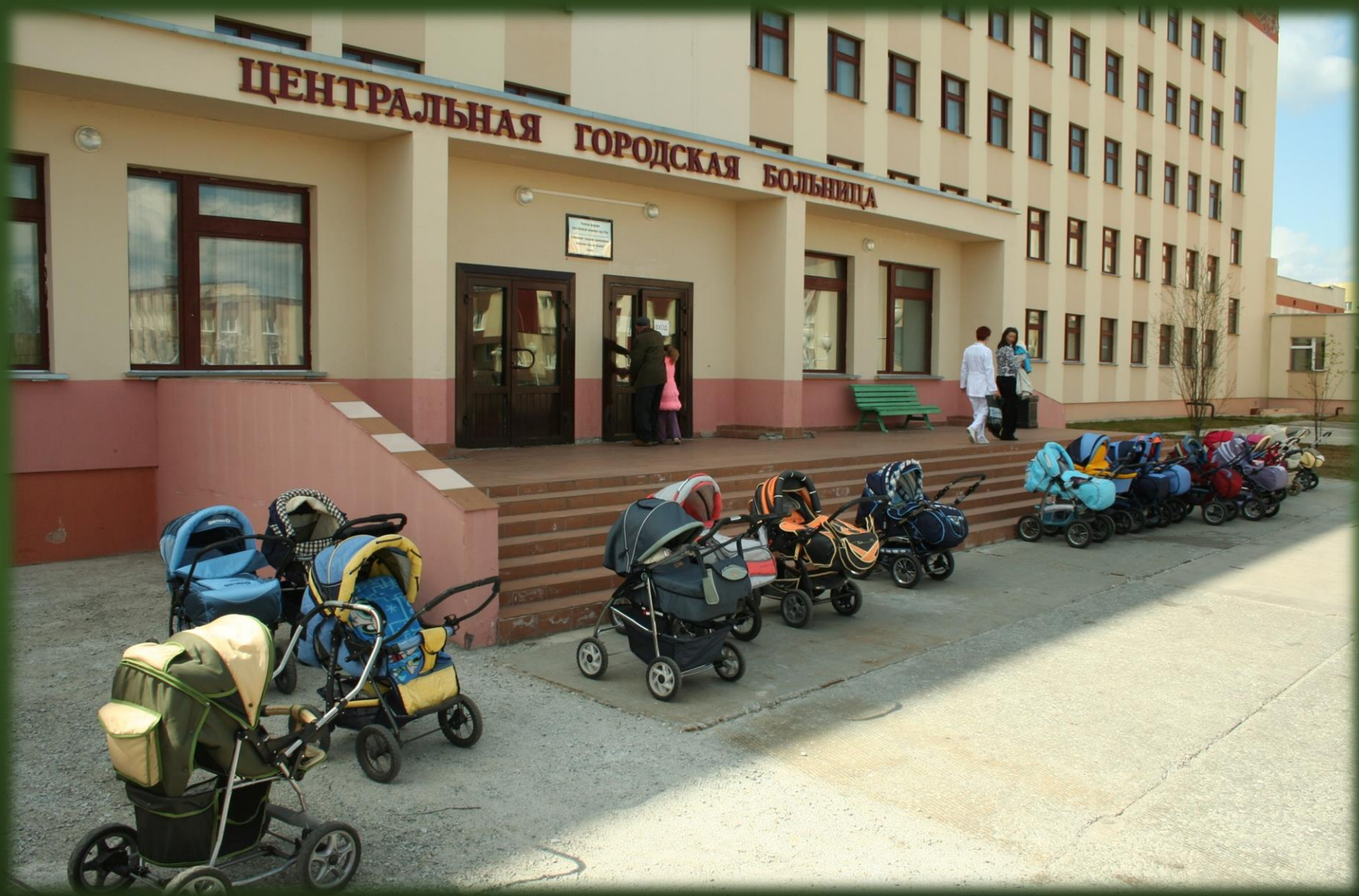
Муниципальное учреждение здравоохранения «Центральная городская больница» г. Покачи, 2003 год
