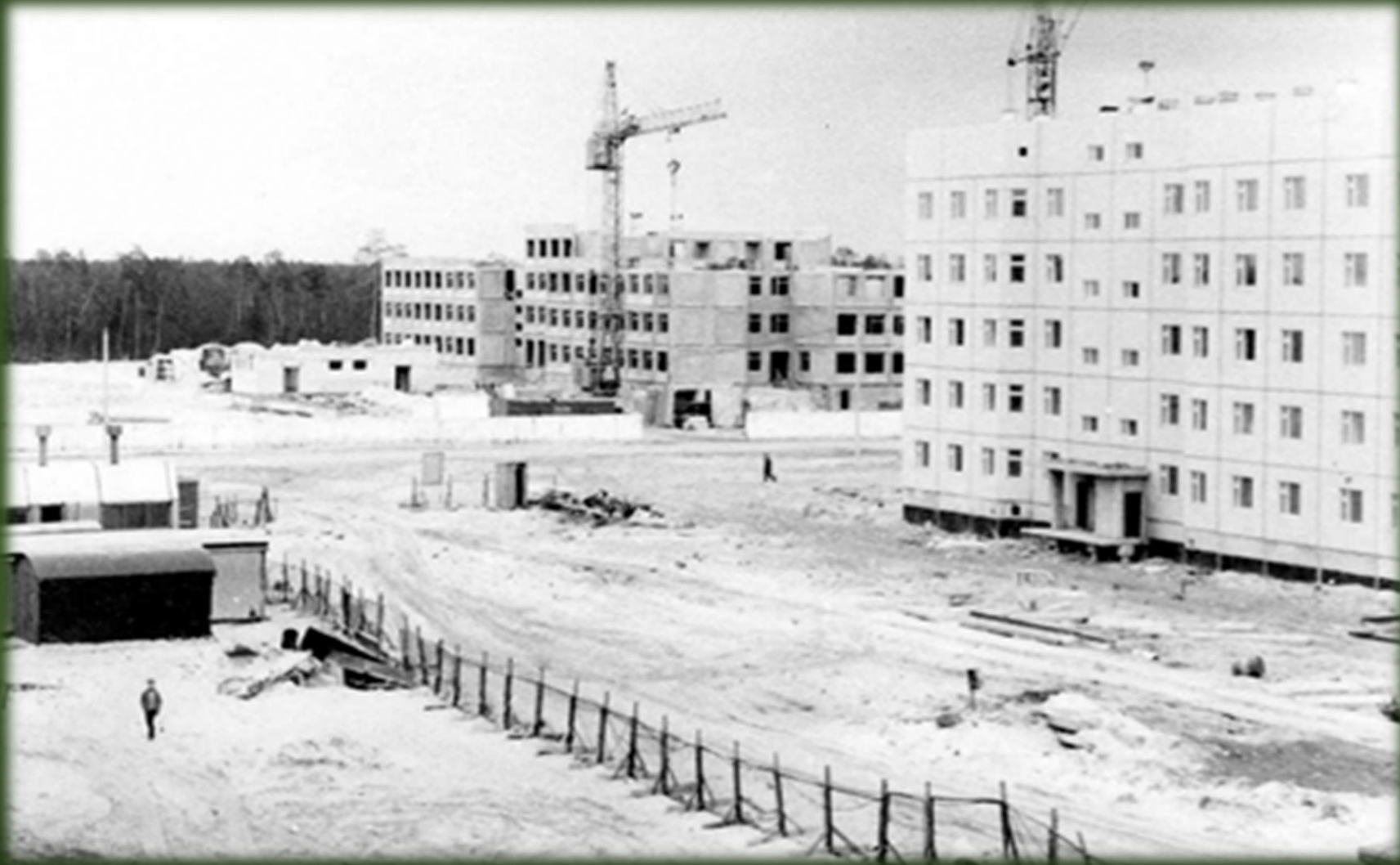
Строительство школы № 2 в поселке Покачи, 1989 год
